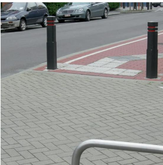
*Trottoir traversant avec dalles pour personnes malvoyantes qui signalent « une traversée », ou plus précisément un croisement possible avec des véhicules. Le revêtement rouge signale la présence d'un arrêt de transport en commun et n'est donc pas une indication de danger.*
