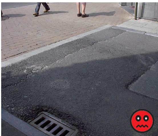
*Dans ce contre-exemple, la rue est à sens unique (vers le trottoir traversant), les automobiles abordent le dispositif à l'aide de cette rampe: par conséquent, ils ne sentent pas de différence de niveau. La vitesse à laquelle les automobiles abordent le dispositif peut être élevée, étant donné qu'ils arrivent en ligne droite. La sécurité des piétons dans ce cas est donc moins assurée.*
