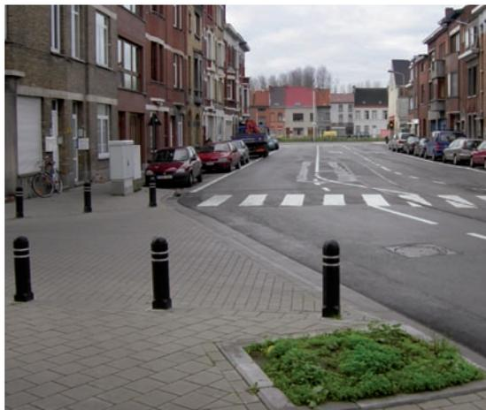
*Le trottoir traversant est en continuité visuelle avec le trottoir bien que le trottoir traversant soit réalisé en pavé béton de taille différente.*
